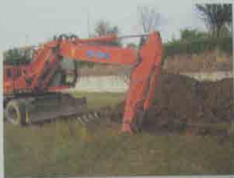
FOTO 3: Operazioni di scavo del pozzetto esplorativo P2
